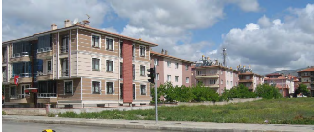
Şekil 79. Ayırık nizam olarak inşa edilmiş binalara örnekler
