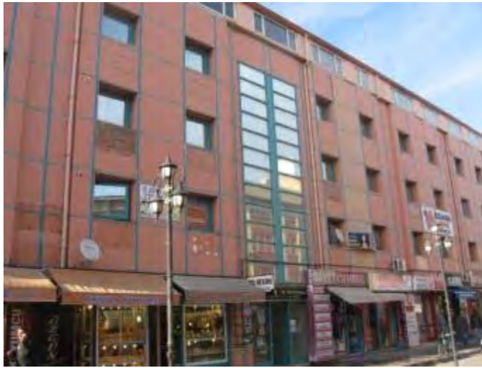
Şekil 77. Kızılay mahallesinde ticari amaçla kullanılmakta olan bir betonarme bina
