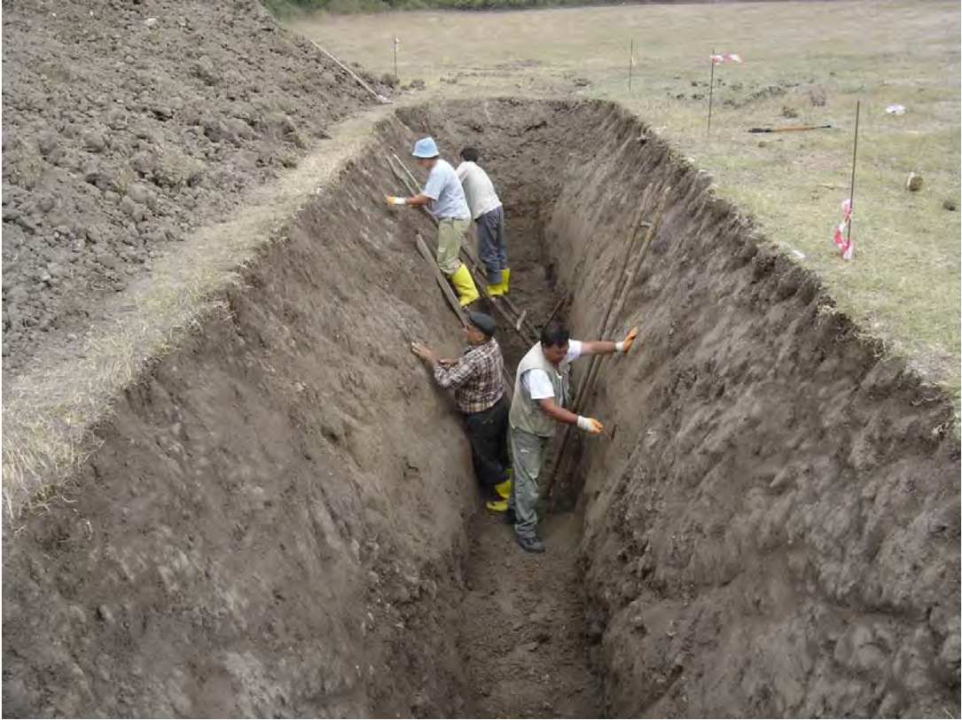
Şekil 4.8. Seyvan hendeği açma ve temizleme çalışmaları
