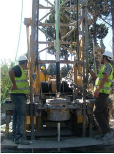
Şekil 2. Sol taraftaki resimde kuyu içi 1 Hz, 2 Hz, 15 Hz sismometreler, sağ taraftaki resimde ise bunların kuyu içine indirilmesi için boruya monte edilmiş haldeki görünümü
